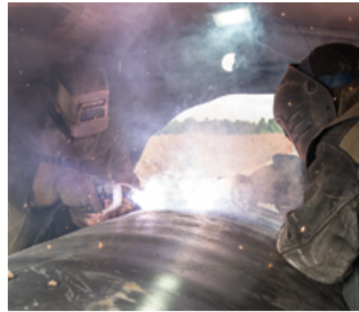
Ремонт МГ Уренгой–Новопсков
