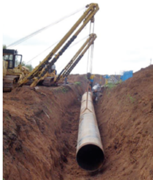
Подключение отремонтированного участка
